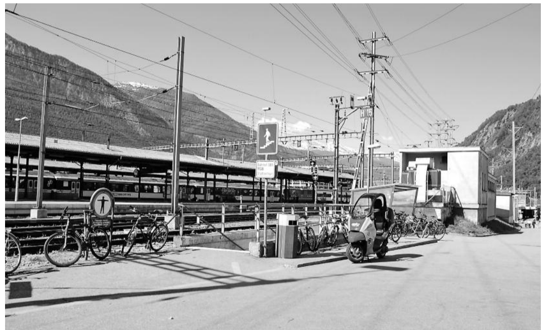
Bessere Erschliessung. Die Perronunterführung nach Naters soll verbreitert werden.
