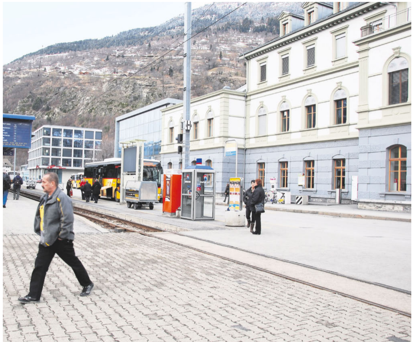
Entschlacken. Konkrete Massnahmen für den neuen Briger Bahnhofraum liegen vor. Ein Baubeginn ist allerdings nicht vor 2017 geplant.
