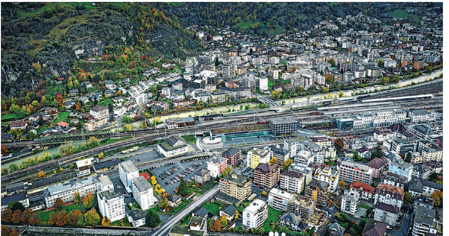
Rund um den Bahnhof Brig soll in den kommenden Jahren viel passieren. 2025 werden nach jetzigem Stand die Bauarbeiten starten.
